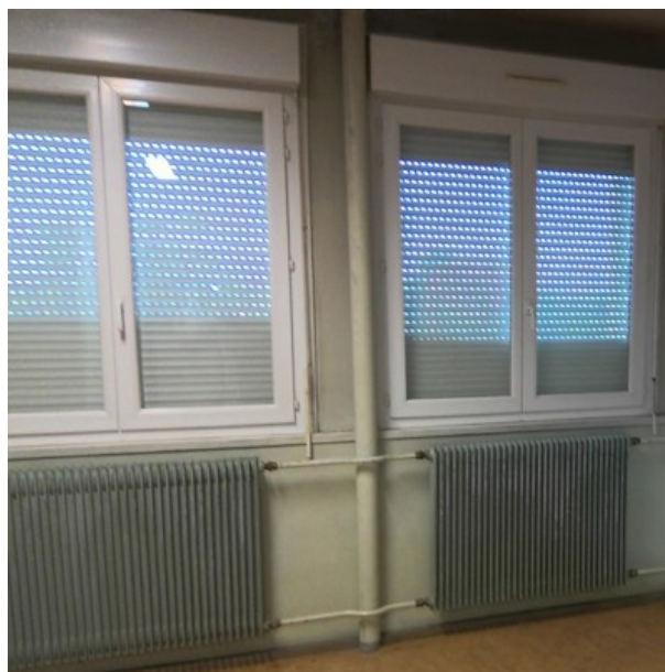
Étage 3 / D2-031 / Conduit en amiante ciment [ Idem Prélèvement n°12]
