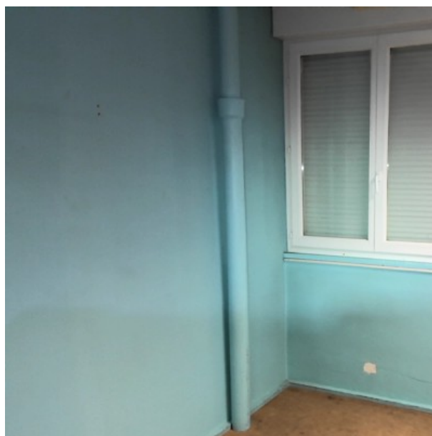
Étage 3 / D2-002 / Conduit en amiante ciment [ Idem Prélèvement n°12]
